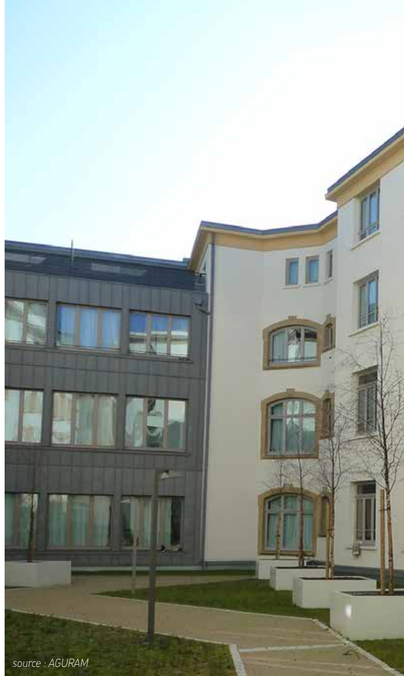
Opération de réhabilitation de l'ancienne maternité Sainte-Croix à Metz
